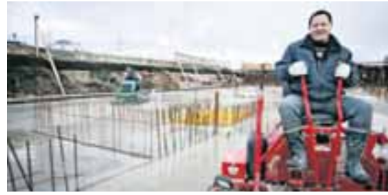
UNNIÐ HRATT Um 1400 rúmmetrar af steypu fóru í plötuna.
