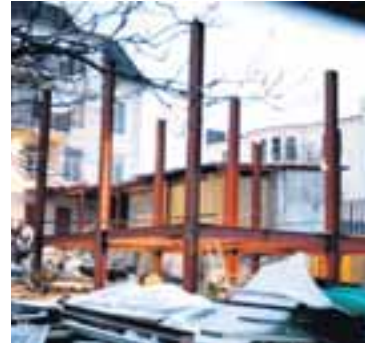
RÚSSAR BYGGJA Í GARÐASTRÆTI Mikið stálgrindarverki er risið á baklóð rússneska sendiráðsins í Garðastræti.
