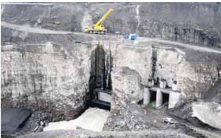
HJÁRENNSLISÓPI LOKAÐ OG HÁLSLÓN VERÐUR TIL Hjárennslisgöngunum var lokað 28. september á þessu ári.
