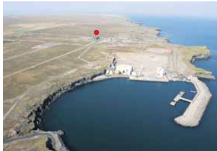
SÉÐ YFIR HELGUVÍK Samtökin Sól á Suðurnesjum krefjast þess að íbúar sveitarfélaganna á Suðurnesjum fái að kjósa um byggingu fyrirhugaðs álvers Norðuráls í Helguvík. Álverið mun rísa á svæðinu á bak við Sorpeyðingarstöð Suðurnesja sem er á miðri mynd. MYND/ODDGEIR KARLSSON
