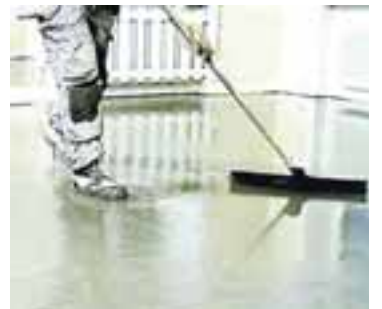
Trefjaflot er notað eins og annað flotefni en hentar betur á trégólf en venjulegt flotefni.
