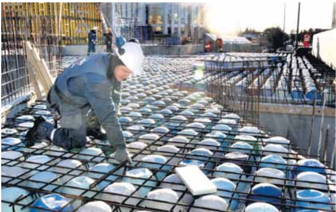
STEYPUVINNA Fjöldi iðnaðarmanna vann að byggingu nýs Háskólatorgis í veðurblíðunni í gær. Áætlað er að nýja Háskólatorgið muni rúma um 1800 nemendur og starfsmenn Háskólans. Stefnt er að vígslu nýbygginganna á haustdögum. FRÉTTABLAÐIÐ/GVA
