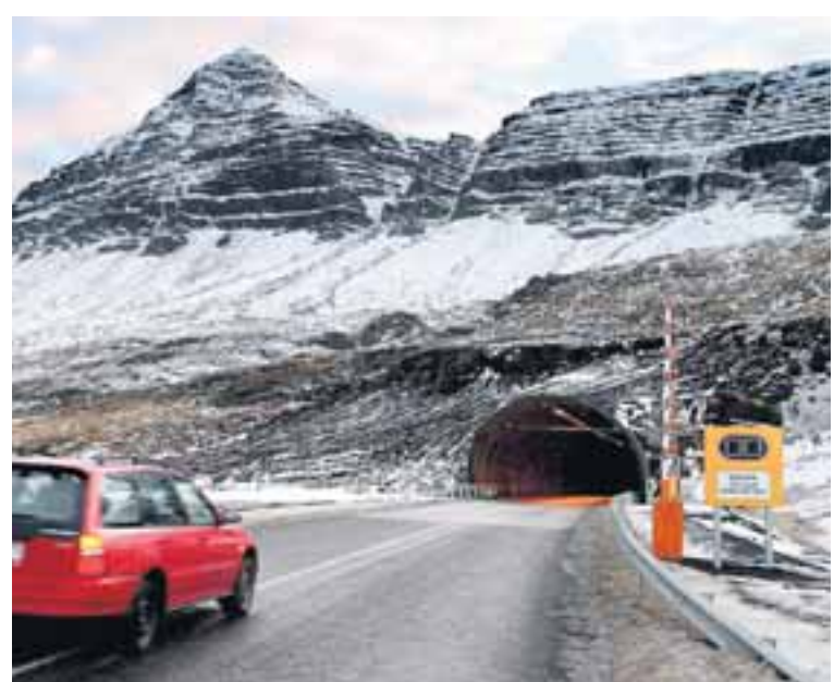
FÁSKRÚÐSFJARÐARGÖNG Verja á 38 milljörðum til jarðganga til ársins 2018 og unnið verður að byggingu tvennra ganga á hverjum tíma. FRÉTTABLAÐIÐ/GVA
