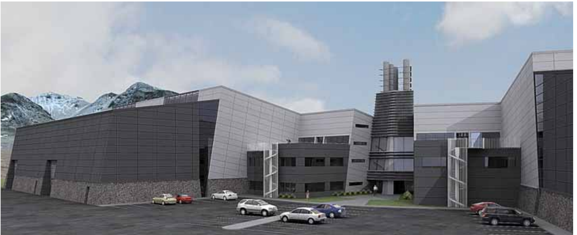
Stöðvarhús Orkuveitunnar á Helliðshéi er tilkomumikil bygging sem óneitanlega minnir á húsnæði úr James Bond-mynd.
