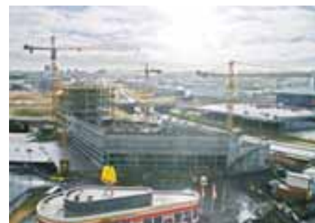
Háhýsið við Smáratorg verður alls 20 hæðir og 77,6 metra hátt. Áætluð verklok eru 1. október á þessu ári.
