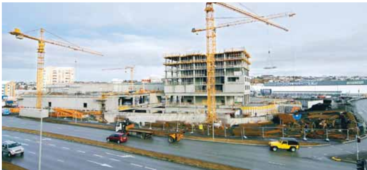
Þrettán daga tekur að fullklára eina hæð í háhýsinu. Nú er verið að leggja lokahönd á þá sjöundu og á því eftir að byggja þrettán hæðir til viðbótar. FRÉTTABLAÐIÐ/ANTON
