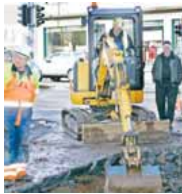
GERT VIÐ Unnið var að viðgerðum fram eftir gærdeginum. FRÉTTABLAÐIÐ/VILHELM
