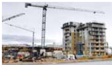
Byggingaframvæmdir standa yfir á Lundi 1 í Kópavogi. Íbúðirnar verða til sölu hjá Fjárfestingu fasteignasölu.
