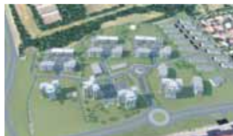
Lundur 1 er hluti af nýju íbúðhverfi sem Byggingafélag Gylfa og Gunnars hf. er að reisa í Lundarhverfinu í Kópavogi.
