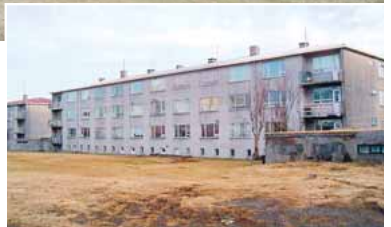
Þessi blokk við Hringbraut var orðin heldur hrörleg.
