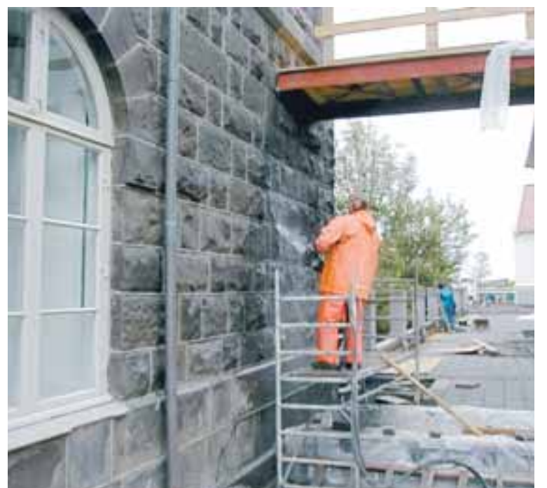
Hér er unnið við Alþingishúsið.
