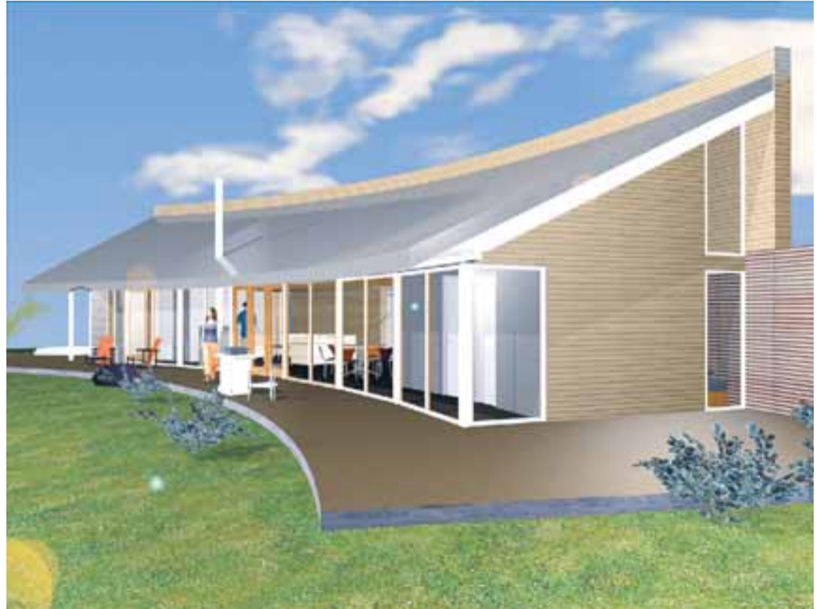
Bogadregna húsið er afar ólíkt því sem venja er í sumarhúsum en í þessu húsi er öll hliðin með gluggum til að hægt sé að njóta útsýnisins sem best. Þá er þakið einnig óvenjulegt þar sem það hallar aðeins í eina átt.
