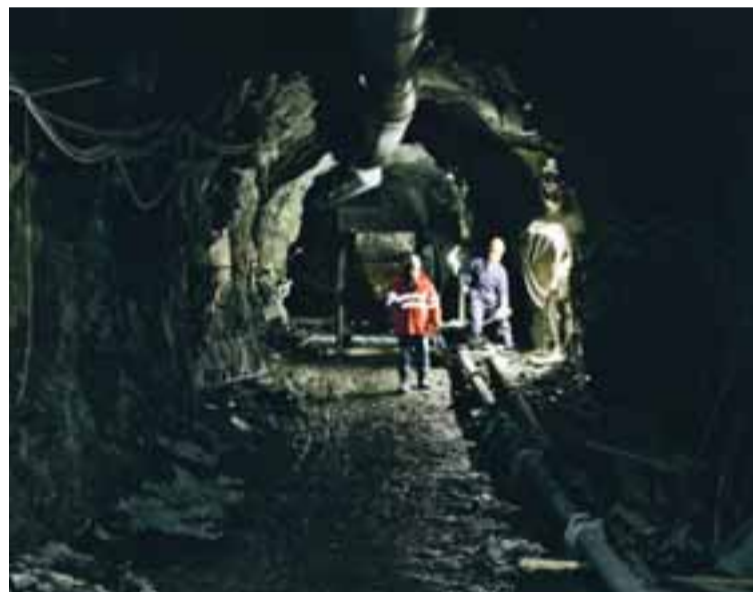
UNNIÐ ER AÐ FRÁGANGI JARÐGANGA Búið er að fjarlægja alla bora og ekkert rafmagn í göngunum. Allar vélar eru knúnar með dísilolíu sem mengar loftið. Fréttablaðið/Wilhelm
