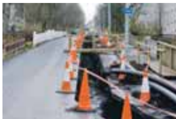
FRAMKVÆMDIR Í MEÐALHOLTI Sviðsstjóri framkvæmdasviðs segir örsjaldan hafa komið fyrir að veggir Reykjavíkinga riðlist eða skemmist við svona framkvæmdir.
