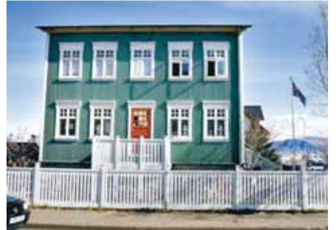
Umskiptin eftir endurbygginguna eru hreint út sagt ótrúleg. Þess skal getið að húsið var að mestu leyti gert upp eftir upprunalegu útliti sínu.
