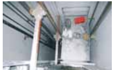
LYFTUGÖNGIN Hér má sjá hvernig málningu var hellt í lyftugöng hússins.
