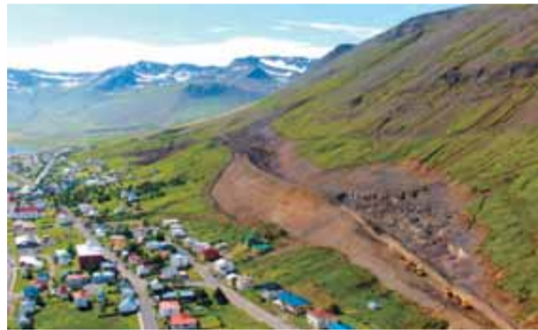
SIGLUFJÖRÐUR Hér sést staða framkvæmdanna við snjóflóðavarnargarðana í ágúst í fyrra. Vinna lá niðri í vetur en hefst aftur í lok maí.
