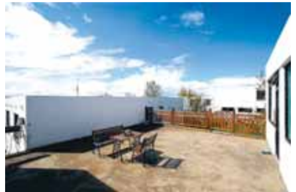
Stór steinsteypt verönd er við húsið.
