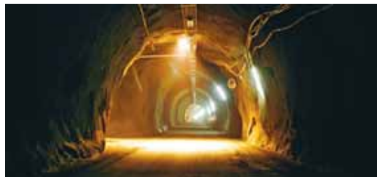
FLJÓTSDALSVIRKJUN Séð inn í aðkomugöng Fljótsdalsvirkjunar í Valbjófsstaðafjalli.
