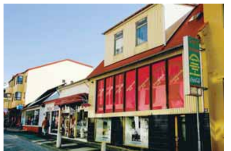
HÚSIN VIÐ LAUGAVEG 4 OG 6 Húsin tvö frá seinni hluta nítjándu aldar verða rifin til að rýma fyrir nýja húsinu.
