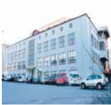
BORGARTÚN Húsið við Borgartún 6 reyndist talsvert minna en uppgæfið var þegar ríkið seldi eignina. FRÉTTABLAÐIÐ/GVA
