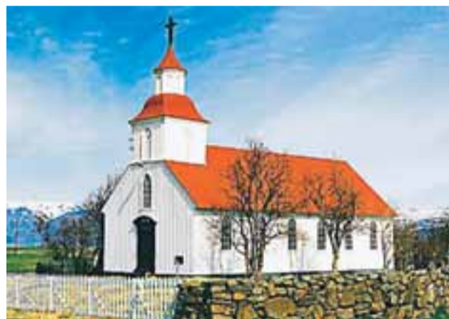
MÖÐRUVALLAKIRKJA Kirkjan var stærsta timburkirkja landsins þegar hún var byggð árið 1867.
