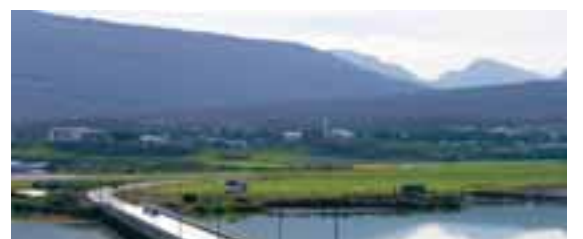
LAGARFLJÓT Bóndinn á hluta af farvegi Lagarfljóts, þar sem vatn úr Kárahnjúkavirkjun mun renna á leið sinni út í sjó. Hann er skyldugur til að taka við vatninu þar sem Landsvirkjun fékk lagaheimild til að stífla Jökulsá á Brú og leiða vatn hennar í nýjan farveg.
