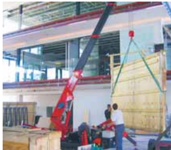
1.300 kg þungum kassa með gleri lyft á sinn stað í nýbyggingu Kaupþings hf. í Borgartúni. Glerin voru allt að 11 fermetrar að stærð og þau þyngstu um 650 kg.
