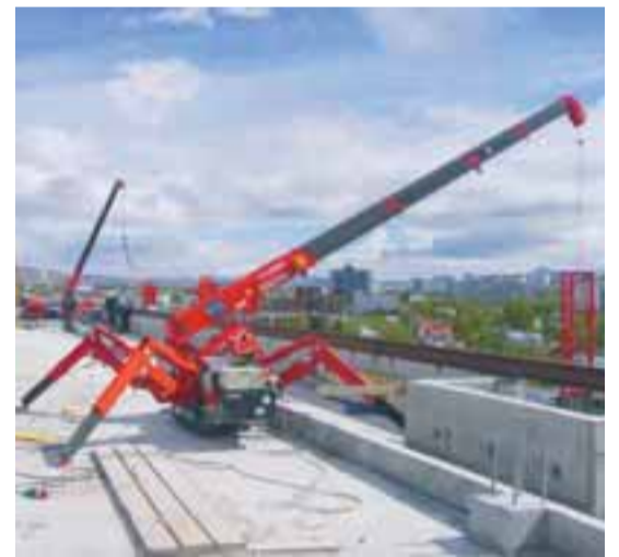
Báðir smákranarnir ofan á þaki nýbyggingar í Höfðatorgsreit sem Eykt hf. er að byggja. Þeir voru notaðir til að setja granítklæðingu á suðurhlíð hússins.
