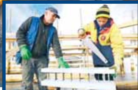
Einu áhöldin sem uppslátturinn þarfnast eru málbönd og sagir.
