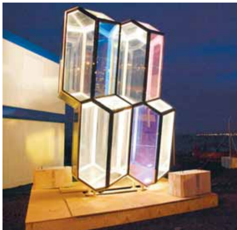
LÍKAN AF STUÐLAGLERI Á lóð tónlistarhússins er líkan í rétttri stærð af stuðlaglerinu sem setja mun svip sinn á bygginguna.
