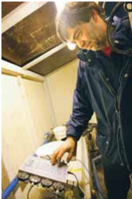
Sjóðælan í sjávardýrasafninu er mikilvæg þeim mörgu lífverum sem þar búa í búrum, en dælan sjar óhreinindi og mengun úr sjónum utan við Laugarnes.
