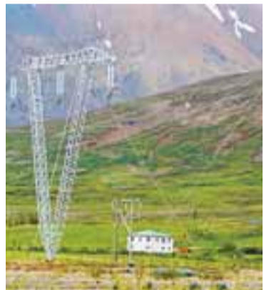
HÁSPENNULÍNUR Í SKRIÐDAL Samtök orku- og veitufyrirtækja vilja efla flutningskerfið í stað dýrari jarðstrengja. MYND/SIGURDUR ARNARSON
