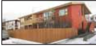
flisum á gólf og útgang á viðarvernd og þaðan í afgyrta garð. Baðherbergi með flisum á gólf og á vegg við baðkar. Svefnherbergin eru þrjú og öll með dúk á gólf og skápum. Verið er að laga húsið að utan og skipta um gler að hluta og er sú framkvæmd á kostnað seljanda. Sérmerkt bílastæði fylgir íbúðinni ásamt bílskúrrétti. Verð 28,6 m.
