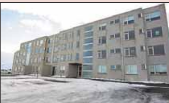
Tilbúin til afhendingar. Glæsilegar sérhæðir að Lækjarvaði í Reykjavík. Íbúðirnar skilast fullbúin að utan og að innan tilbúnar til innréttinga. Allir innveggir hlaðnir. Hítalögn í gólfum. Dósir fyrir halogenlýsingu í stofu og holi. Reykrör fyrir arinn fylgja hverri íbúð. Að utan skilast húsið steinað í ljósum lit. Húsin eru á tveimur hæðum með einni íbúð á hvorri hæð og fylgir bílskur og stórar svalir á bílskúrpaki með efrí sérhæðinni. Lóðin er skipt í sér eignarhluta fyrir hvora íbúð, að framanverðu er upphit að bílastæði við bílskúrinn, að auki er sérstæði fyrir neðri hæð og tvö önnur sameiginleg bílastæði. Lóðin verður tyrfð bakatil, bílapan og aðkoma frágengin. Snjóbræðsla er fyrir framan bílskur og í aðkomu.
