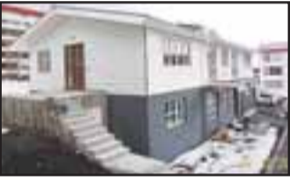
ingum Hurðir frá Parket og gólf. Húsið er einangrað að utan og klætt með lituðuáli. Inn og útveggr endurnýjaðir einnig er lagnir endurnýjaðar. Nánari upplýsingar og teikningar fást hjá sölumönnum Hússins.
