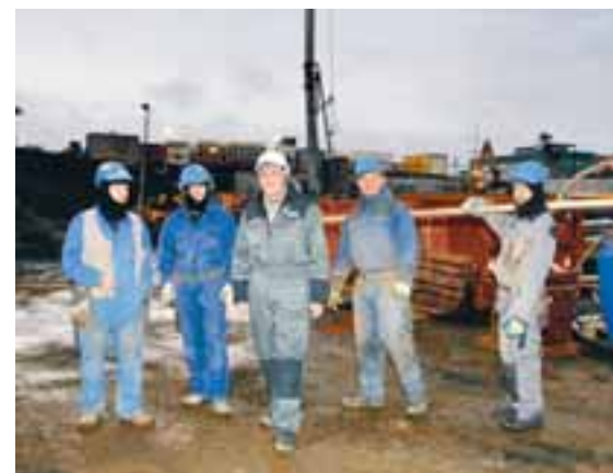
Glaðir iðnaðarmenn Byggingafélags Gylfa og Gunnars sem stefna á verklok haustið 2009.
