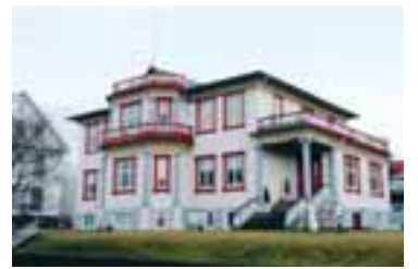
Íslensk afbrygði af timburhúsagerð byggja ekki síst á miklu flúri, þetta má sjá til dæmis í því hvernig gluggakarmar hafa verið skreyttir. Hér má sjá slíkt við Frikirkjuveg 11.
