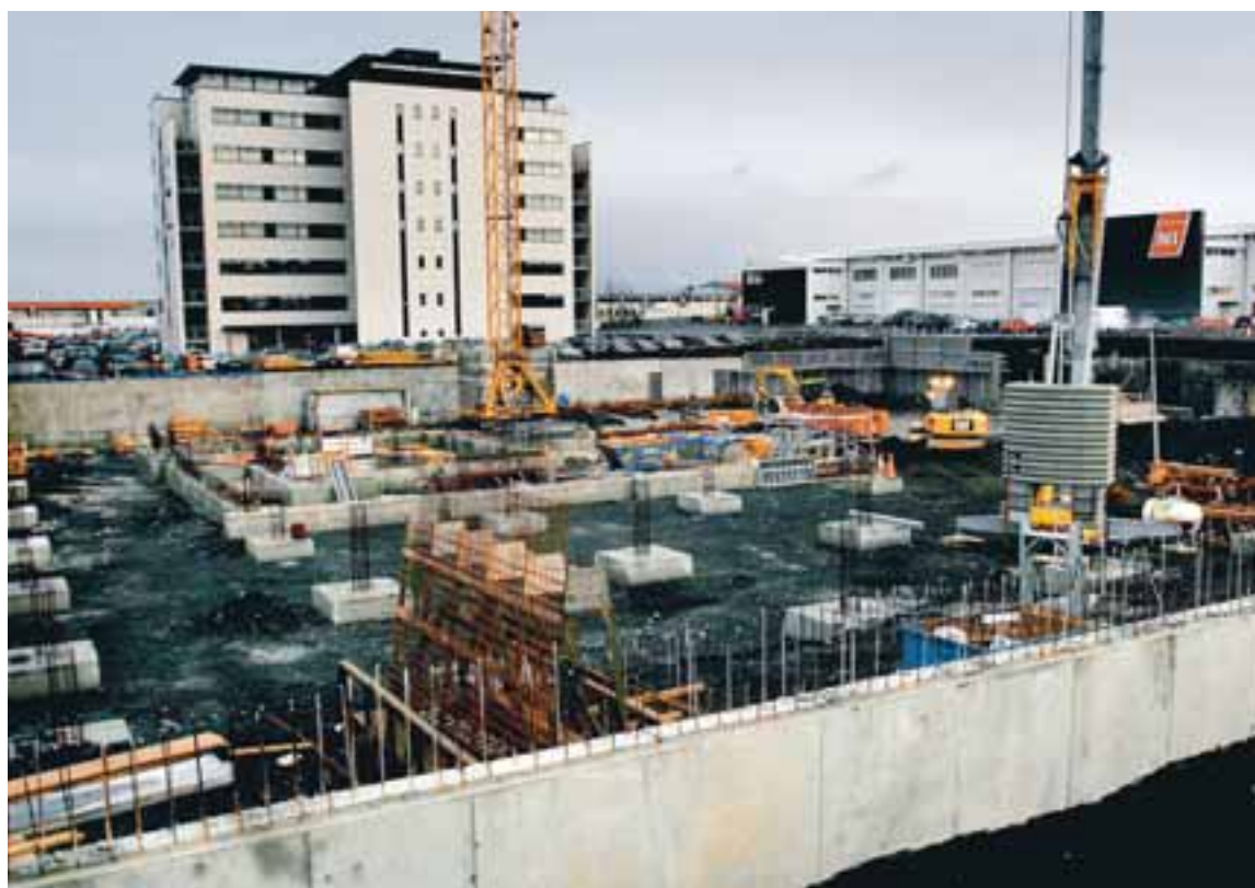
Verkið er á grunnstigi og verið að slá upp grunninum.
