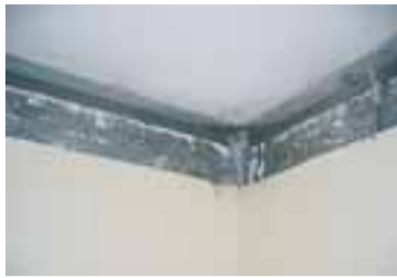
SKEMMDIRNAR Unnið er að því að ráða niðurlögum myglusvepps í stúdentaíbúðum á gamla varnarsvæðinu.
