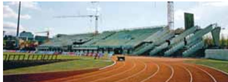
FRAMKVÆMDIR Upphafleg áætlun vegna framkvæmda við Laugardalsvöll hljóðaði upp á 1.068 milljónir króna. Þær fóru hundruð milljóna fram úr áætlun.
