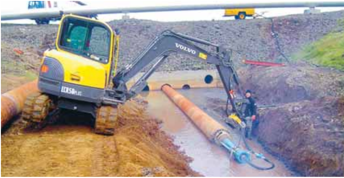
Ottó segir að með notkun stýranlegra jarðbora við gatnamannvirkjagerð þurfi ekki lengur að bora heilu vegina í sundur með tilheyrandi óþægindum.
