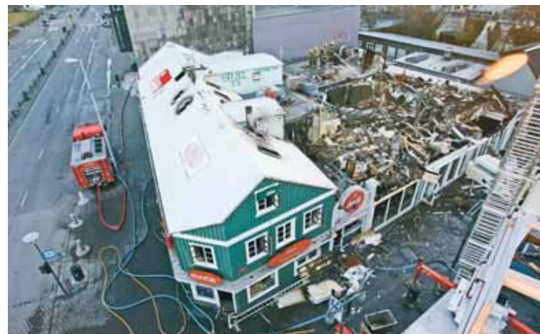
EYÐILEGGING Húsið að Lækjargötu 2 stórskemmdist en Austurstræti 22 eyðilagðist. Mörg hundruð gömul hús hér á landi eru talin vera í hættu vegna ófullnægjandi brunavarna.
