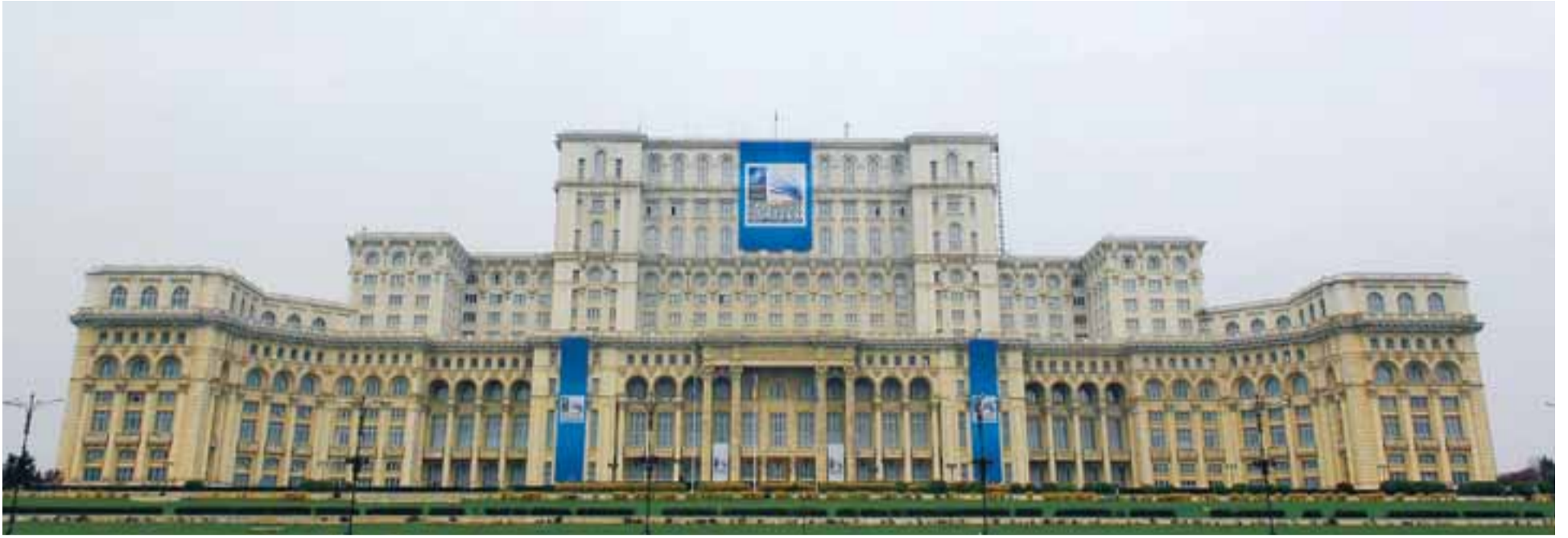
HÖLL ALPÝÐUNNAR Í BÚKAREST Leiðtogafundur Atlantshafsbandalagsins var haldinn í þessari 330 þúsund fermetra byggingu, sem er næststærsta skrifstofubygging heims á eftir Pentagon í Bandaríkjunum. Höllin var reist á árunum 1983-1989 að undirlagi einræðisherrans Ceausescu sem ætlaði hana undir alla stjórnslu Rúmeníu. Í dag er þar rúmenska þingið auk þess sem þar eru haldnar fjölmennar ráðstefnur. FRÉTTABLAÐIÐ/NATÓ
