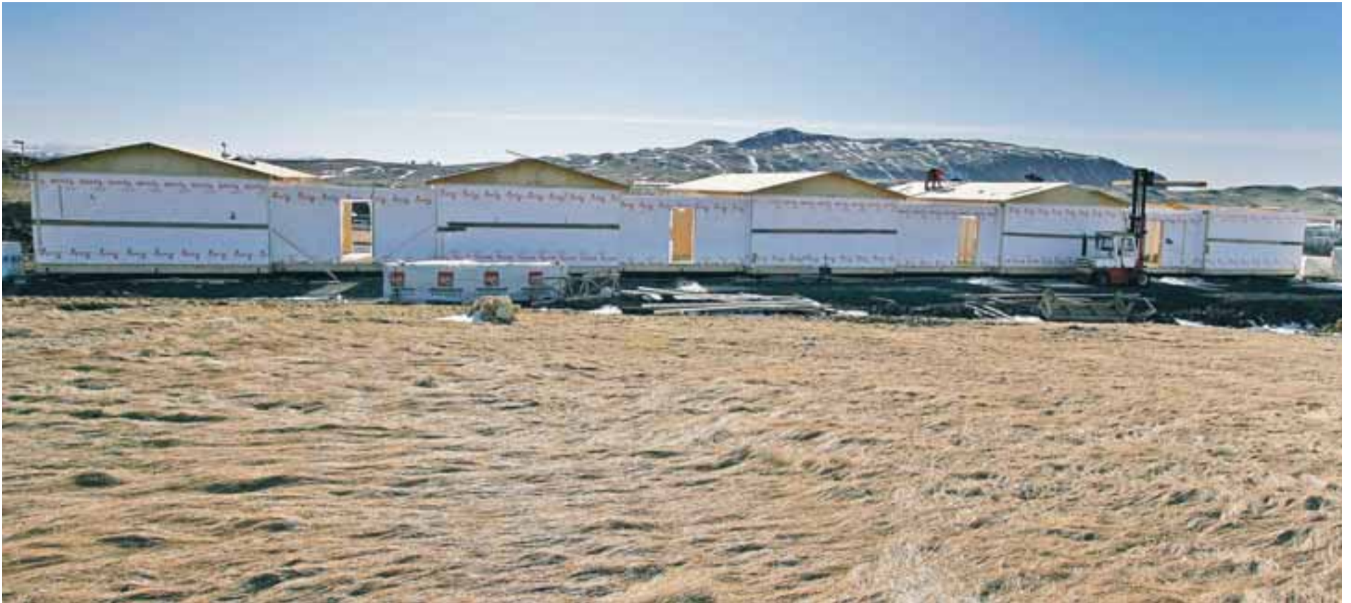
Færanlegu kennslustofnum er hægt að raða saman eftir hentugleika. Hver eining er um áttatíu fermetrar að flatarmáli og millibyggingarnar 25 fermetrar. Fimm stofur mynda samstæða byggingu.
