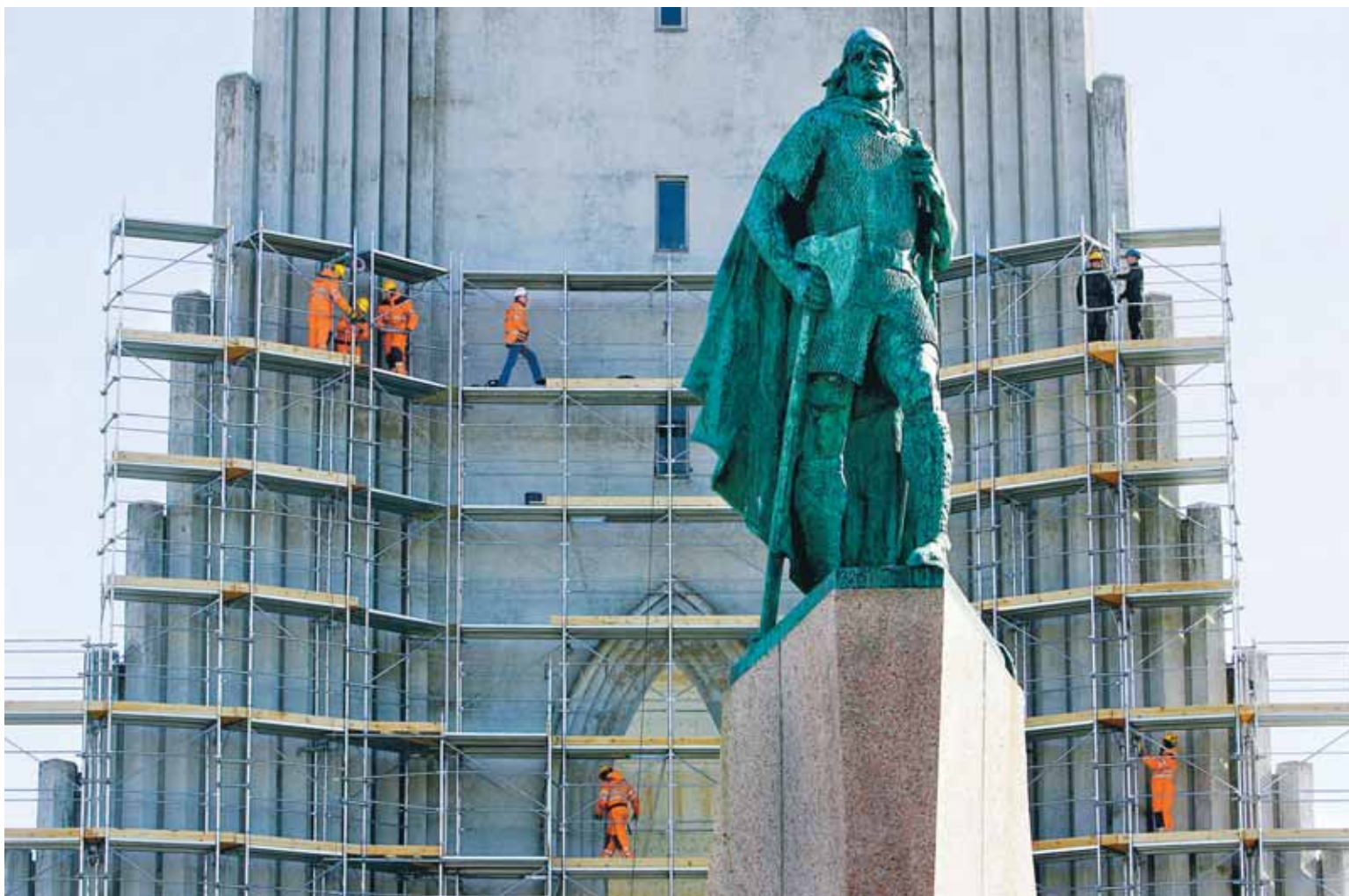
VIÐGERÐ HAFIN Vinnupallar fíkra sig upp eftir turni Hallgrímskirkju þessa dagana vegna steypuviðgerða sem standa munu næstu tólf til átján mánuði. Vinnupallarnir munu áður en yfir líkur ná upp á topp kirkjunnar, eða í 74 metra hæð. Viðgerðin mun kosta um 250 milljónir króna og verður kostuð af ríkissjóði, Reykjavíkurborg og Þjóðkirkjunni.
