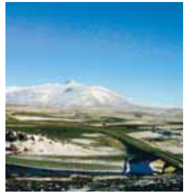
KJALVEGUR Norðurvegur ehf. vill byggja heilsársveg um Kjöl.
