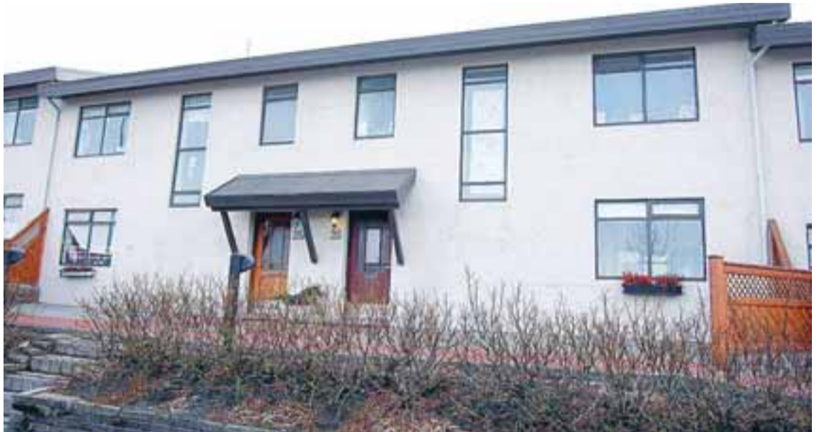
Mikið endurbætt raðhús á Álfhólsvegi og dren og vatnslagnir eru nýlega endurnýjaðar svo og þakfni hússins.
