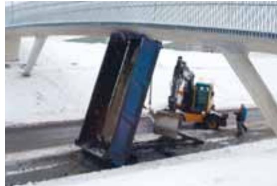
ÓHAPP Á VATNSENDAVEGI Vörubíll var talinn ónýtur eftir að bílstjórinn ók á göngubrú við Vatnsendaskóla.
