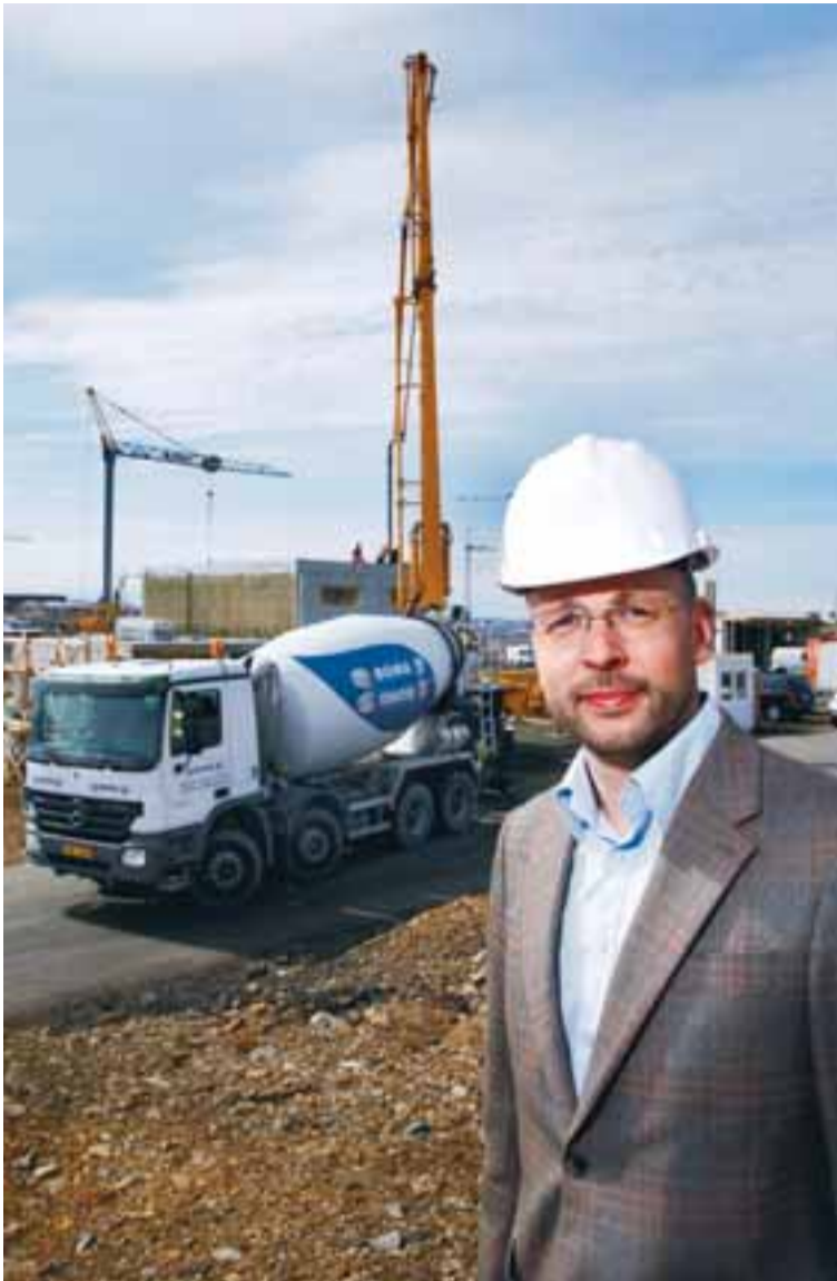
Hermann Guðmundsson, framkvæmdastjóri steypu- og einingaverksmiðjunnar Borgar, segir forsteyptar einingar þægilegri lausn þegar steinsteypt hús eru byggð.
