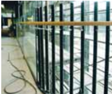
Hér gefur að líta handrið sem Benedikt vinnur að á Suðurlandsbraut. Það er úr stáli, gleri og harðvið. FRÉTTABLAÐIÐ/VALLI
