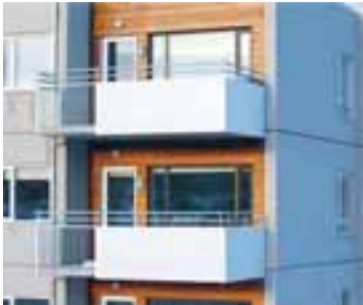
Vinsælt er að hafa hluta svala opnar með stálpílurum, en annan hluta lokaðan fyrir veðri og vindum. MYND/STÁLI Í STÁLI
