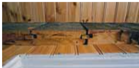
Flestir útveggir hússins eru gerðir úr plönkum sem eru fjaðraðir saman. Þetta nefnist standandi klæðning.
