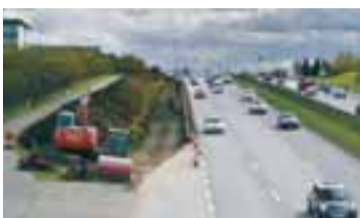
FRAMKVÆMDIR Á MIKLUBRAUT Nýja forgangskreinin er eingöngu ætluð strætisvögnum og leigubílum.
