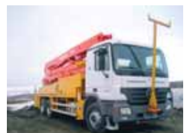
Steypudælubíllinn gegnir veigamiklu hlutverki á virkjanasvæði Hraunaveitu.
