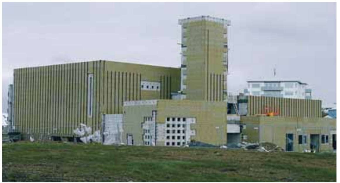
Framkvæmdir við Lindakirkju ganga vel og er áætlað að taka hana í notkun að hluta í haust.
