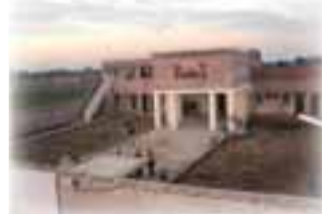
ABC skólinn í Farooqabad – verið er að byggja tvær kennslustofur ofan á hægri vænginn.
