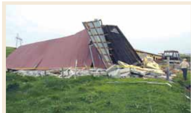
FJÁRHÚSIN AÐ KROSSI Ábúendur á Krossi eru meðal þeirra sem rýmt hafa hús sín vegna skemmda í kjölfar skjálftanna en nokkrar kindur og lömb drápuast þegar hlöðuveggur féll inn í fjárhúsin á bænum.
