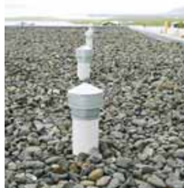
Malarþök eru ódýrasta útfærslan á flötum þökum. Sjávarmólin heldur þakdúknum niðri.
