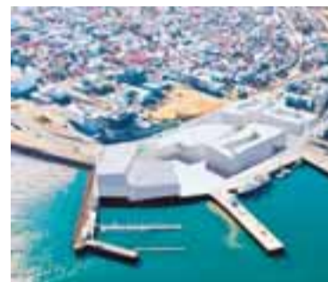
STÓRFRAMKVÆMDIR Stokkurinn fer niður við hringtorgið sunnan Tónlistar- og ráðstefnuhússins og kemur upp við Tollhúsið.
