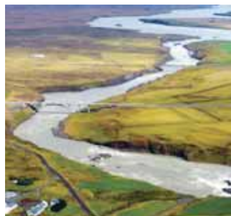
ÞJÓRSÁ Aætlað er að virkjanirnar þrjár sem fyrir-hugaðar eru í Þjórsá hafi samanlagt 265 MW afl, en til samanburðar er afl Kárahnjúkavirkjunar 690 MW.
