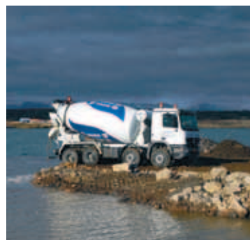
STEYPUBÍLL FRÁ BORG Þessi mynd náðist af steypubíl frá Einingaverksmiðjunni Borg dæla steypu í sjóinn. Myndin var tekin á síðasta ári. MYND/RAYMOND
