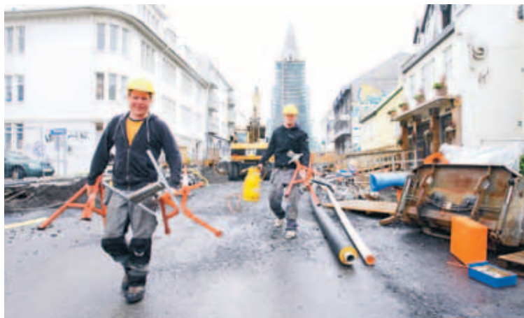
FRAMKVÆMDIR Endurbætur á Skólavörðustíg hófust í mars og hafa gengið samkvæmt áætlun. Þeim verður væntanlega lokið um miðjan ágúst.
